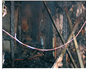
Bild 2: Niederspannungsanlagen (bis 1000 V)
